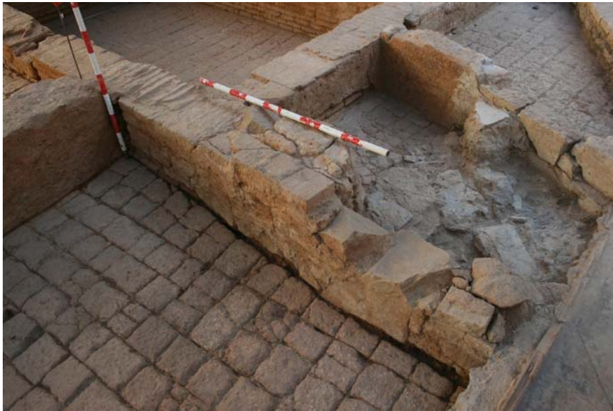
Vista des del sud del mur UE 2071
